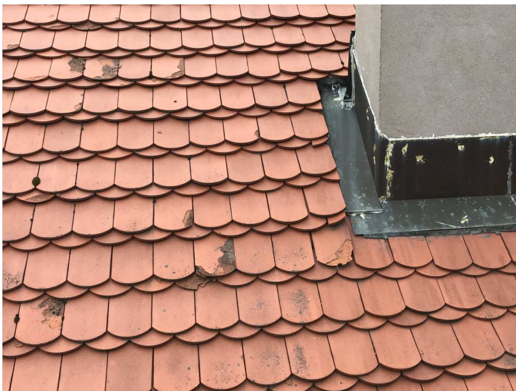
Dachówka nowa – widoczne wady
